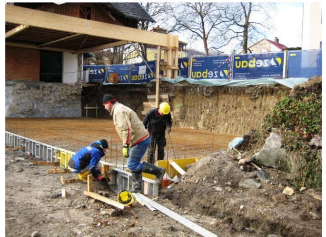
Die Bodenverhältnisse sind günstig, die Baugrube hält, die Bodenplatte ist betoniert.
